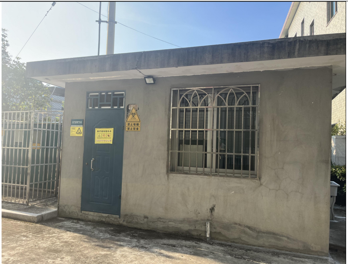
现有医疗废物临时贮存设施
